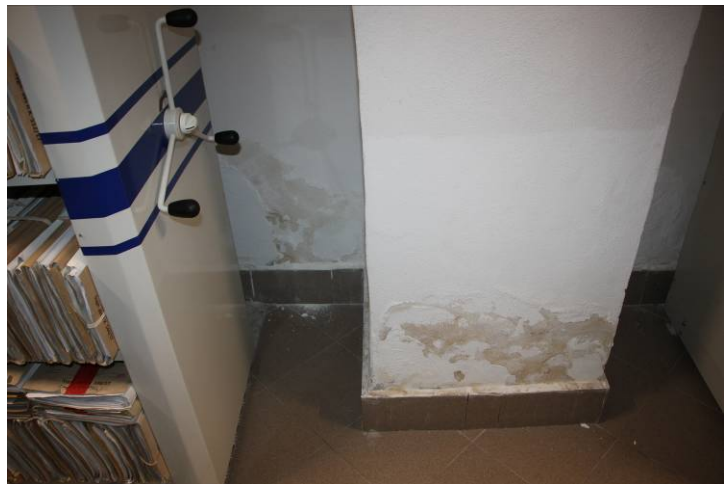
Fotografia nr. 8 Zbliżenie na typową formę uszkodzeń tynków wynikająca z zawilgocenia przegród pionowych.
