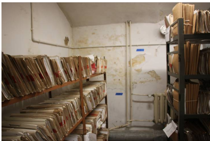
Fotografia nr.1 Zdjęcie przedstawia zły stan zachowania wypraw tynkarskich w archiwum Sądu Rejonowego w Brzesku.
