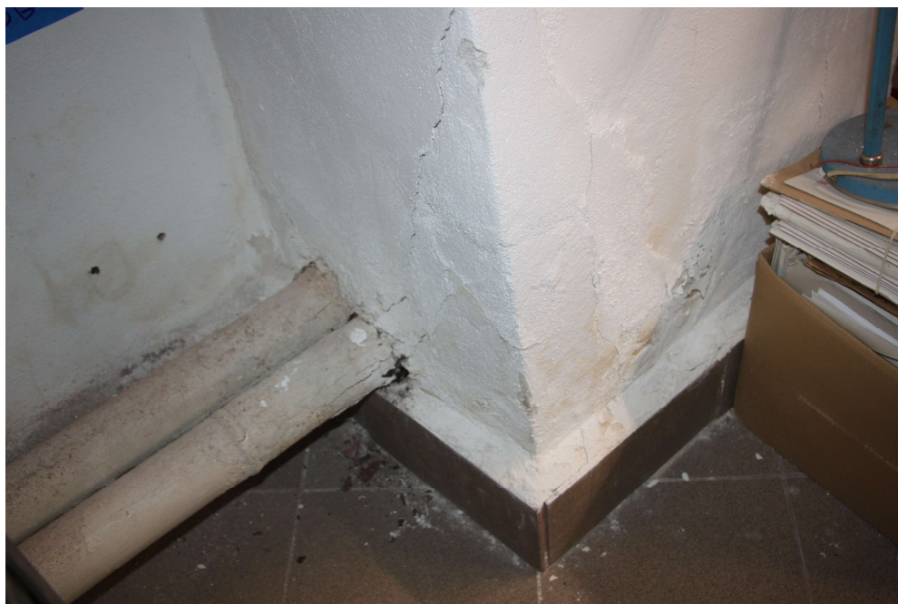
Fotografia nr. 33 Widoczny uszkodzony filar wraz z przeprowadzonymi rurami instalacji.
