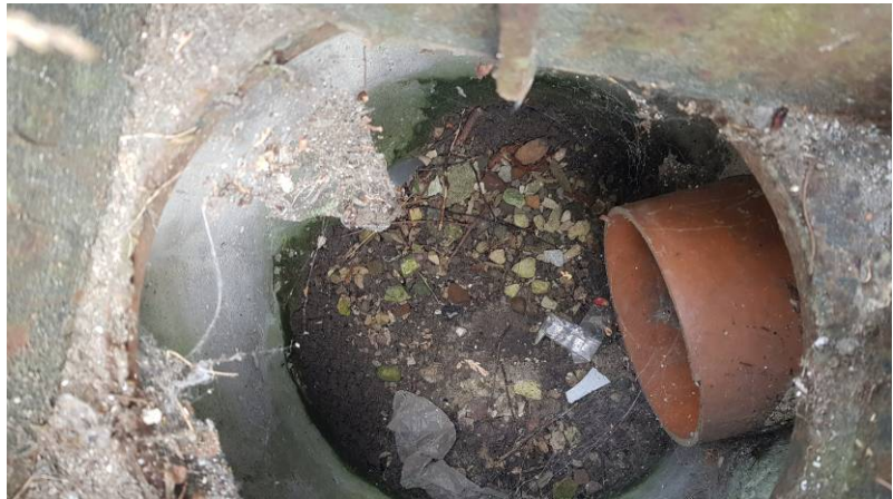
Fotografia nr. 28 Zdjęcie przedstawia stan techniczny wnętrza studzienek kanalizacji deszczowej.
