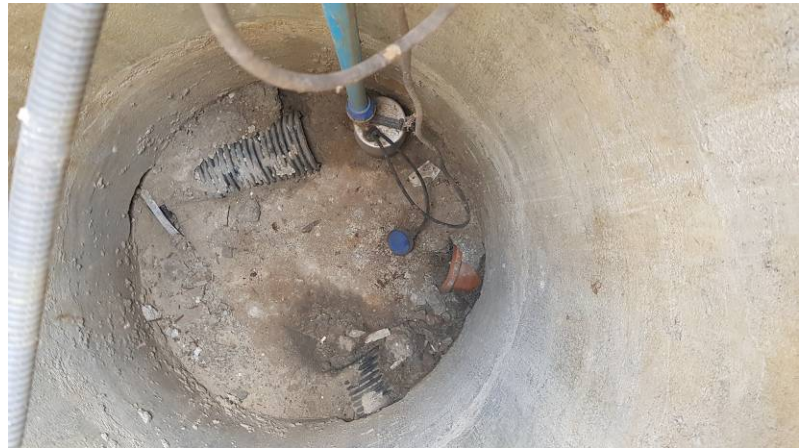
Fotografia nr. 25 Zdjęcie przedstawia stan techniczny wnętrza studzienek kanalizacji deszczowej. Widoczne zamulenie i zasyp dna studzienki.
