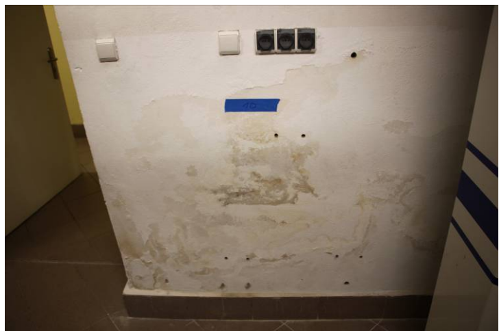
Fotografia nr. 5 Reprezentatywne zdjęcie obrazujące wysoki i znaczny stopień zawilgocenia ściany w archiwum wraz z degradacją tynków ściennych.
