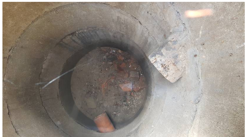
Fotografia nr. 26 Zdjęcie przedstawia stan techniczny wnętrza studzienek kanalizacji deszczowej. Widoczne zagruzowanie dna studzienki.
