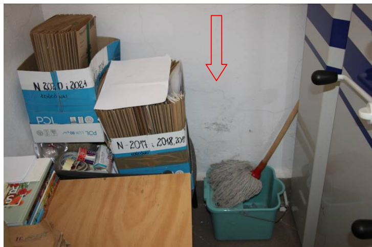
Fotografia nr. 14 Zdjęcie przedstawia uszkodzenia tynków wynikające z zawilgocenia ścian.
