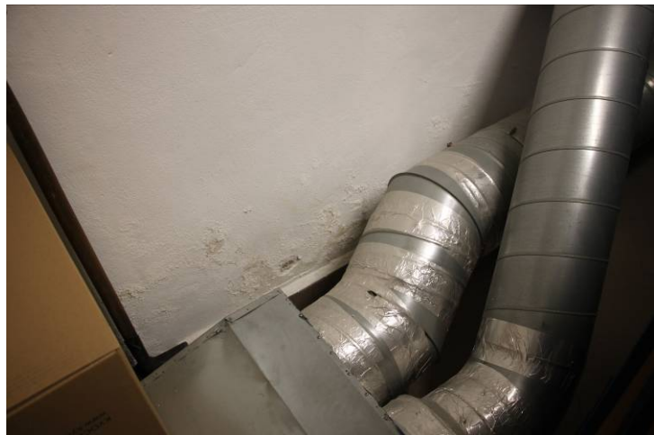
Fotografia nr. 11 Zdjęcie przedstawiające uszkodzenia tynków ściennych. Widoczne instalacje, które niewątpliwie będą utrudniać prowadzenie prac remontowo-zabezpieczających.
