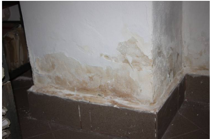
Fotografia nr. 4 Zdjęcie przedstawia skalę destrukcji tynków na filarze ceglanym w pomieszczeniu archiwum.
