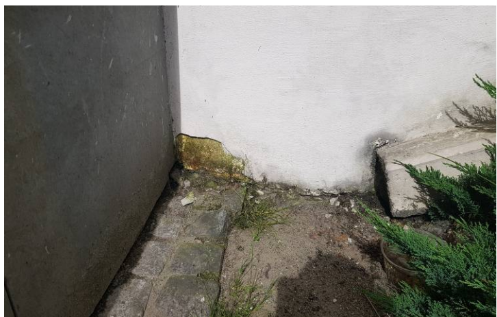
Fotografia nr. 24 Zbliżenie przedstawiające skalę zjawiska związanego z zbieraniem się wody w narożniku po stronie północno-zachodnim.
