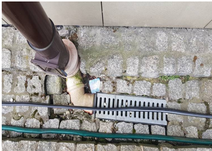
Fotografia nr. 23 Zdjęcie przedstawia formę odwodnienia liniowego przy korycie po stronie północnej budynku. Rozwiązanie techniczne nieskuteczne.
