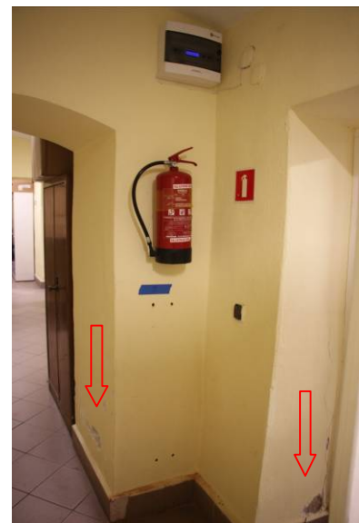
Fotografia nr. 15 Zdjęcie przedstawia uszkodzenie tynków ściennych w bezpośrednim otoczeniu działającego urządzenia służącego do emisji pola elektromagnetycznego.
