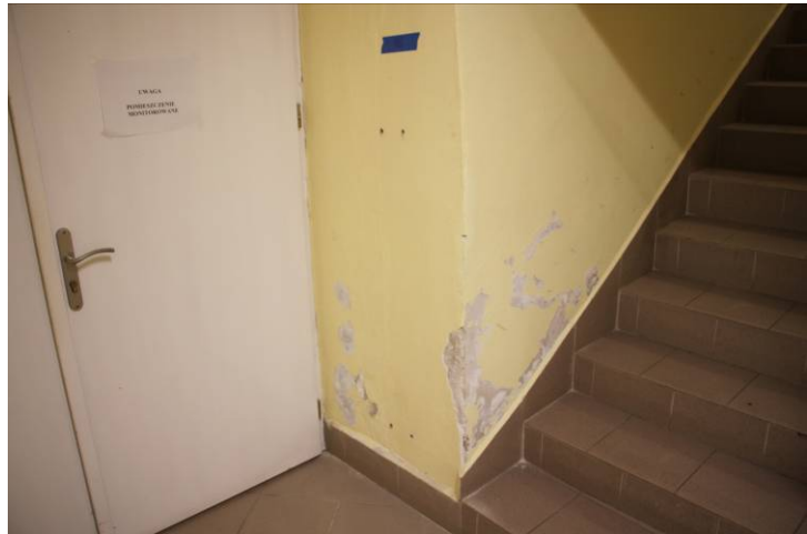
Fotografia nr. 10 Zdjęcie reprezentatywnych uszkodzeń tynków w obszarze korytarza kondygnacji piwnicy.
