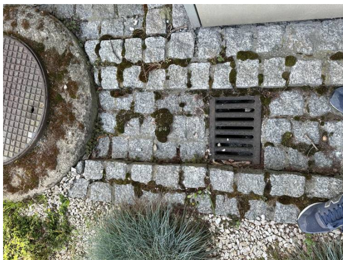
Fotografia nr. 20 Zdjęcie przedstawia studzienkę kanalizacji deszczowej po stronie północnej (elewacja frontowa). Brak oznak skutecznego działania elementu.
