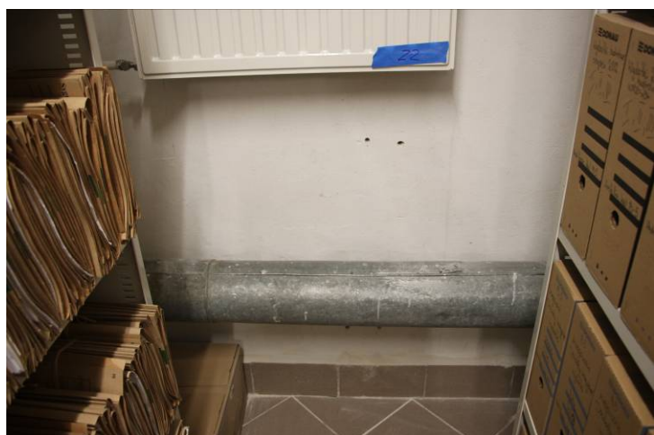
Fotografia nr. 12 Zdjęcie stanu zachowania tynków po stronie południowej. Brak widocznych oznak degradacji wypraw tynkarskich.
