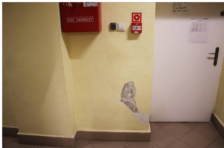
Fotografia nr. 9 Zdjęcie reprezentatywnych uszkodzeń tynków w obszarze korytarza kondygnacji piwnicy.
