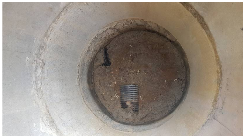
Fotografia nr. 27 Zdjęcie przedstawia stan techniczny wnętrza studzienek kanalizacji deszczowej. Widoczne zamulenie dna studzienki oraz wylotów rur.
