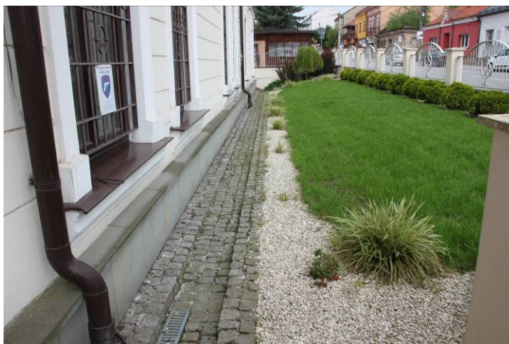
Fotografia nr. 16 Zdjęcie przedstawia uformowane koryto po stronie północnej budynku (elewacja frontowa) mające odprowadzać wodę opadową do kanalizacji deszczowej. Forma elementu i sposób wykonania nie zapewnia skutecznego odprowadzania wód opadowych.
