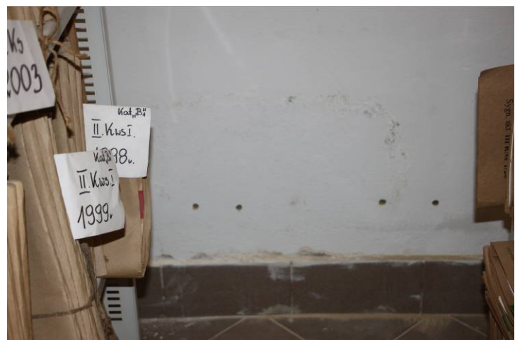
Fotografia nr. 6 Zbliżenie przedstawiające degradację tynków dolnego pasma ściany oraz miejsca prowadzenia badań zawilgocenia ścian metodą nawiertów.
