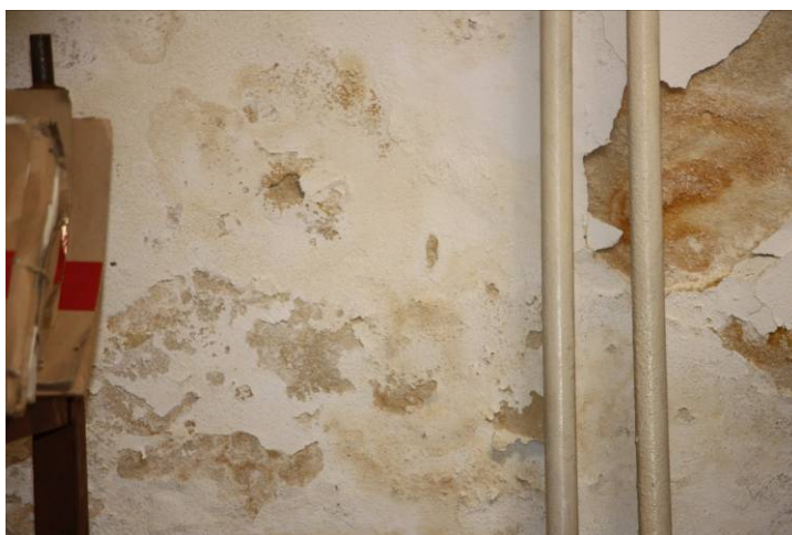
Fotografia nr.2 Zbliżenie na uszkodzenie wypraw tynkarskich, wskazujące na wysoki poziom zawilgocenia przegród pionowych.
