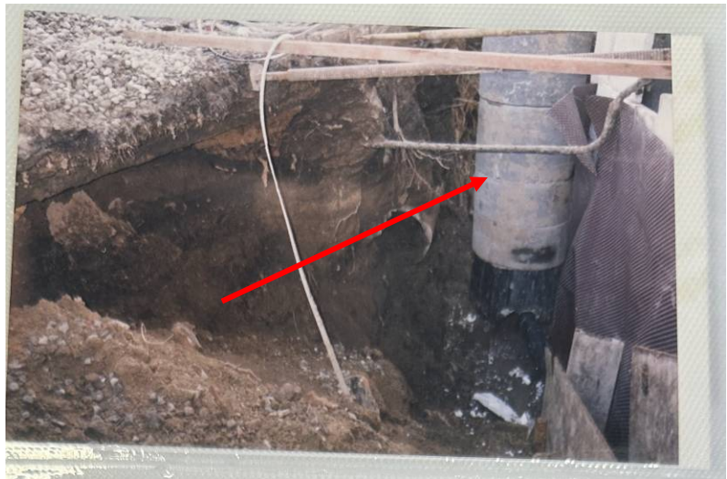
Fotografia nr. 29 Skan archiwalnego zdjęcia. Widoczne nieszczelne łączenia kręgów betonowych.
