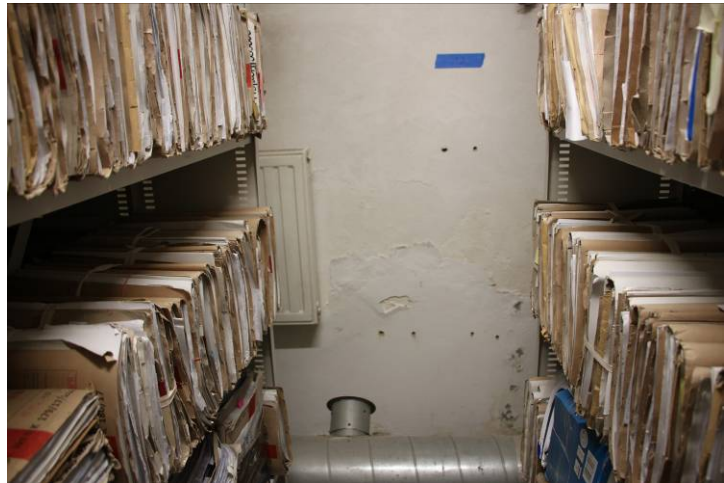
Fotografia nr. 7 Zdjęcie przedstawia skalę degradacji tynków w pomieszczeniu archiwum.
