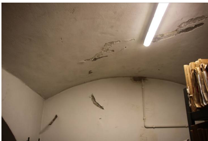
Fotografia nr.3 Widok uszkodzenia tynków na podniebieniu sklepienia w pomieszczeniu archiwum.
